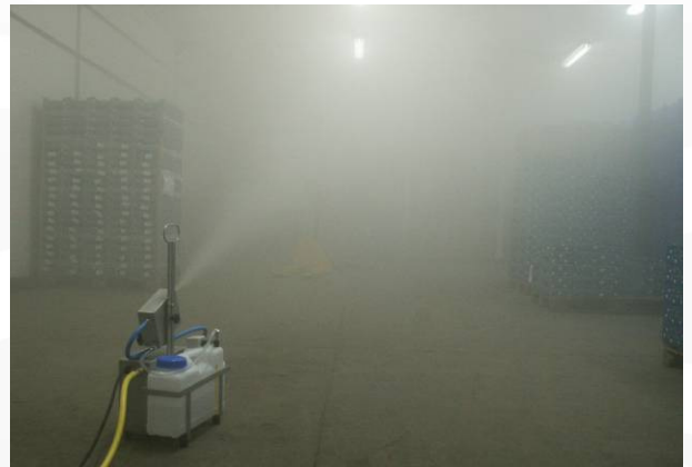
Luftbefeuchtung in Kühlslagern
